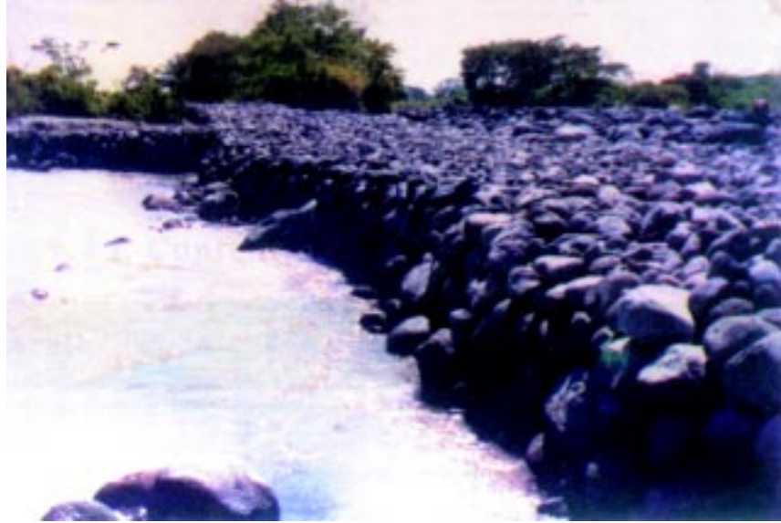
Borda de rocas de pequeño y mediano tamaño, de 1.7x5 metros (alto y ancho) en el río Samalá, San Sebastián, a nivel del cantón Parinox, para desviar las aguas y proteger la cuenca del río Ixpatz, verano de 1986. Trabajo realizado en la finca de hule Las Delicias para su defensa. Destruído por los lahares de 1988
